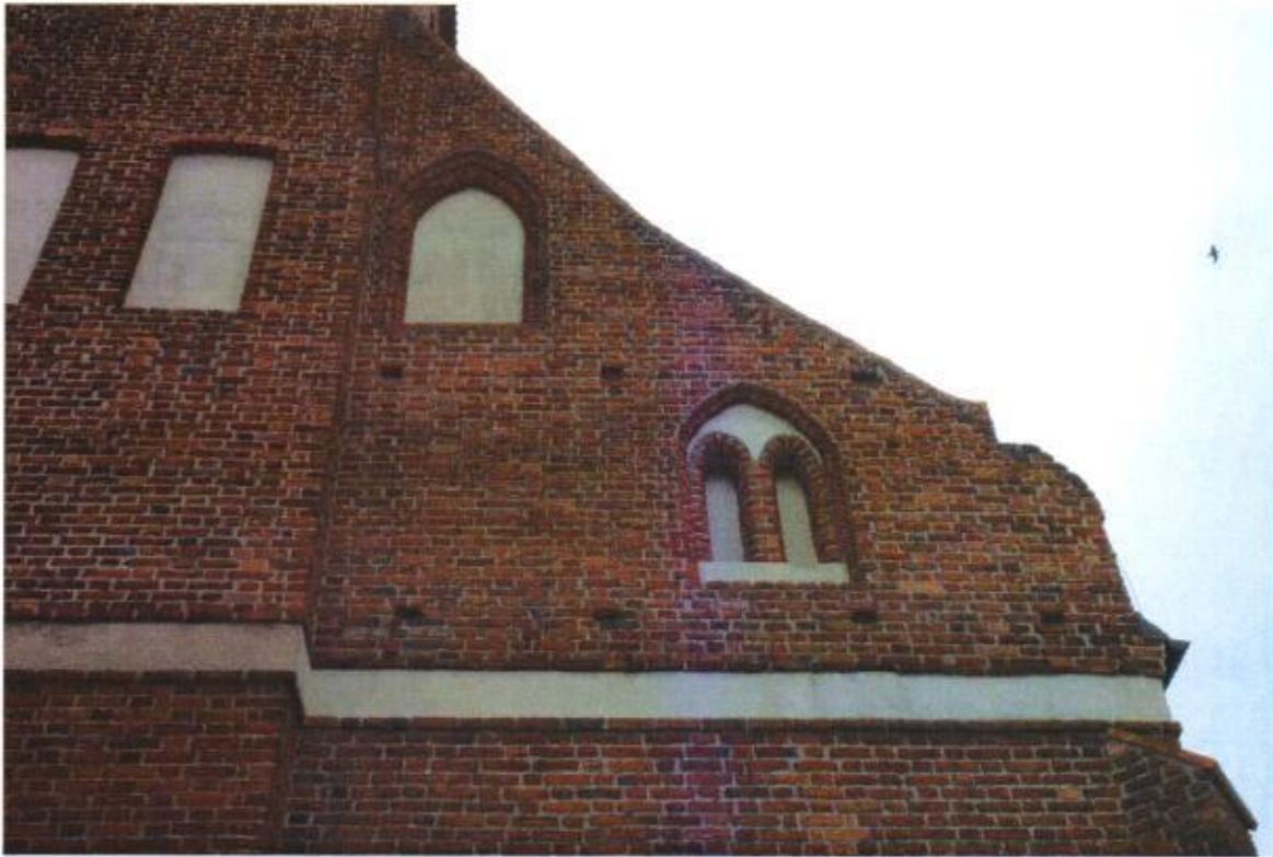
Fot.2. Grudziądz, pw. św. Mikołaja Bpa. Południowa część elewacji zachodniej.
