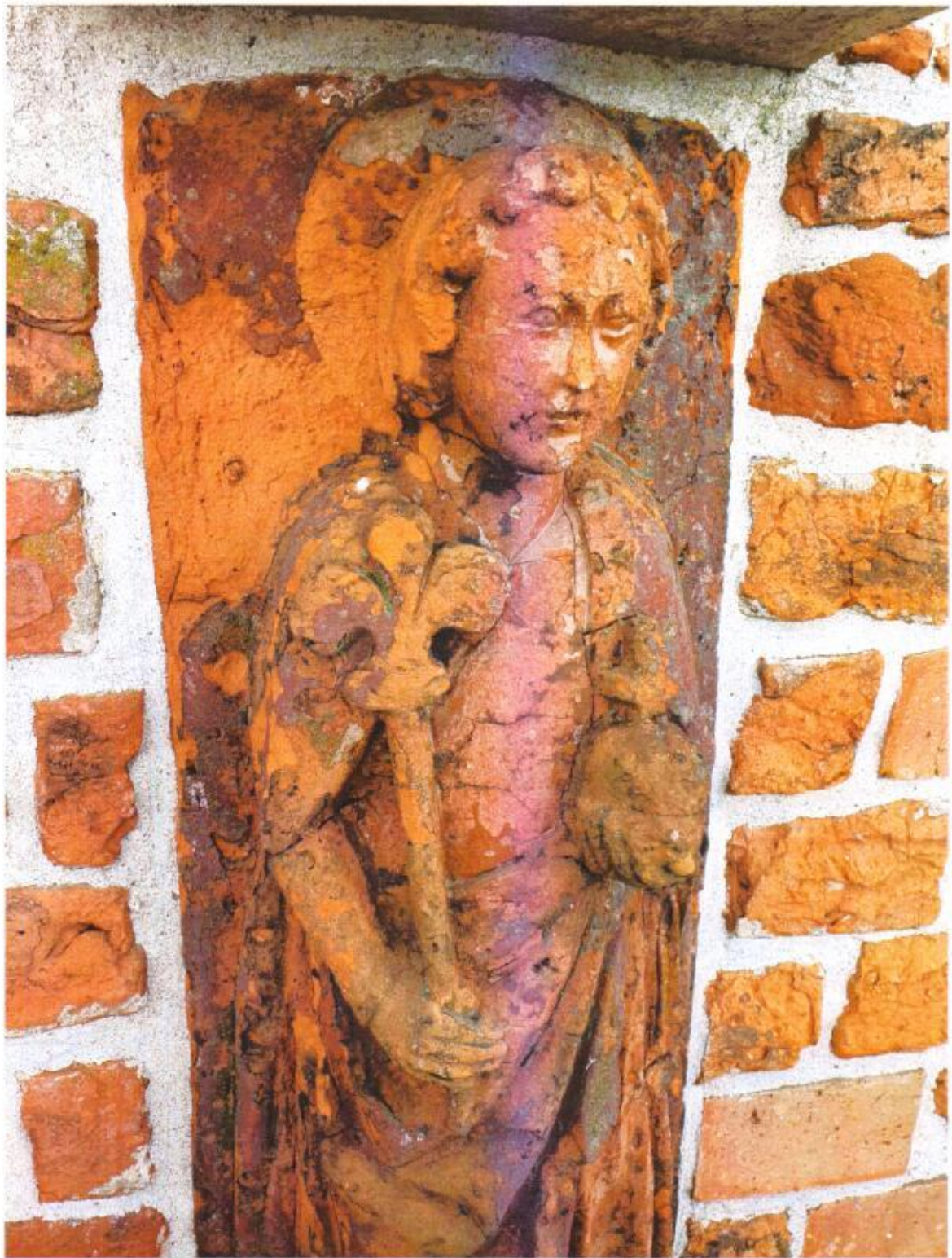
Fot.9. Grudziądz, pw. św. Mikołaja Bpa. Rzeźba Chrystusa. Widoczne rozległe zruszczenia lica. Ceramika jest silnie skorodowana o wtórnie rozwiniętej powierzchni.
