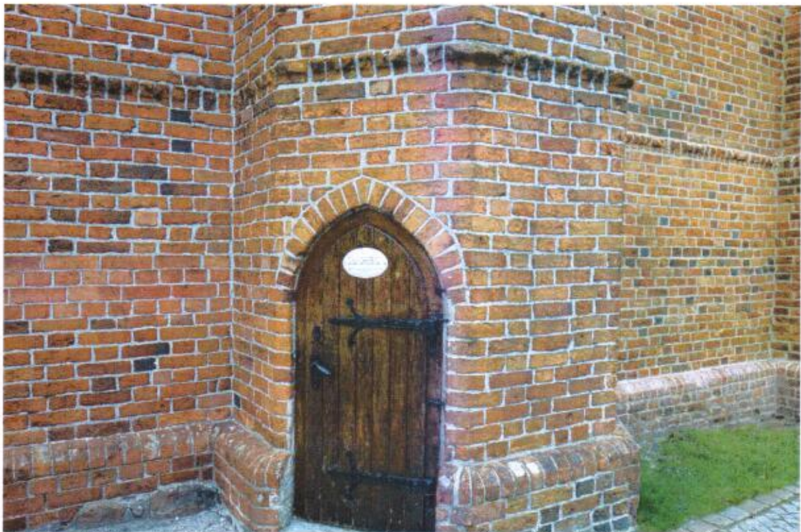
Fot.5. Grudziądz, pw. św. Mikołaja Bpa. Przyziemie północnej części elewacji zachodniej wraz z klatką schodową wieży.
