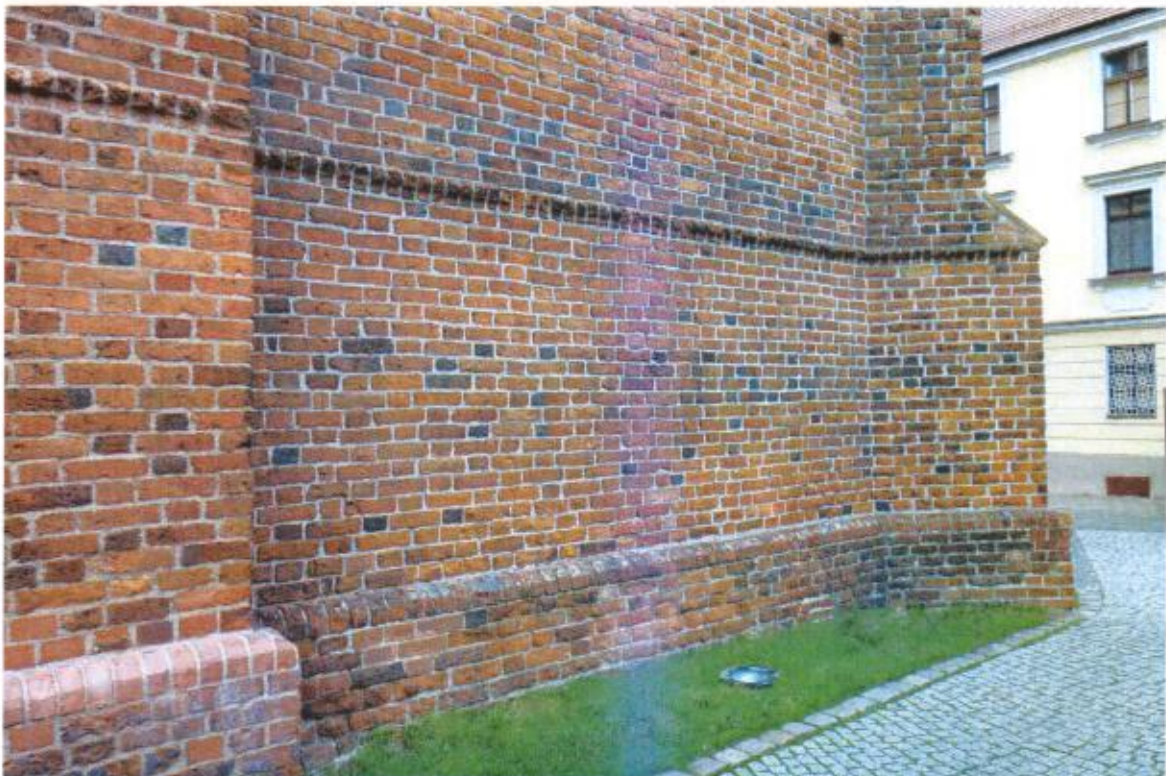
Fot.3. Grudziądz, pw. św. Mikołaja Bpa. Przyziemie, południowej części elewacji zachodniej.
