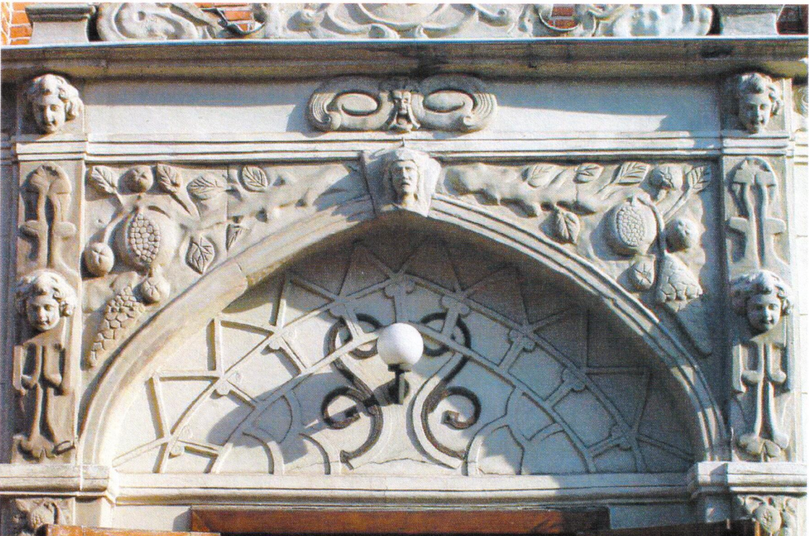
Fot.16. Grudziądz, Kościół pod wezwaniem św. Mikołaja, portal, nadproże widoczne wyoblenie detalu.
