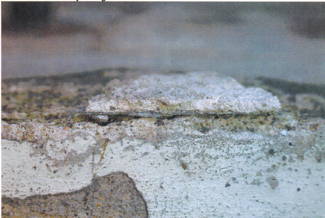
Fot.1. Grudziądz, Kościół pod wezwaniem św. Mikołaja, fragment tynku z elewacji kruchty, widoczne kolejne warstwy tynku, na dole cementowa warstwa wierzchnia.
